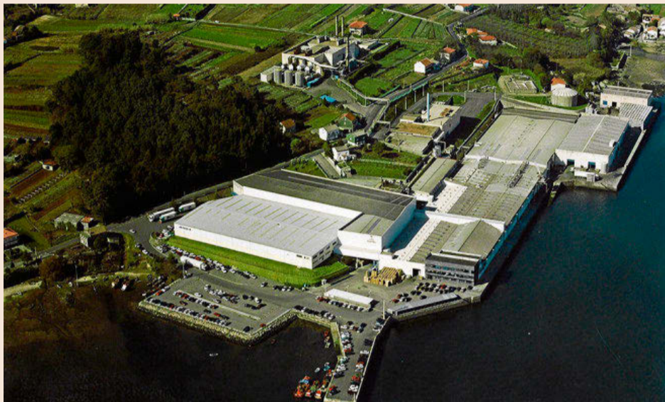
Vista aérea de las instalaciones de Jealsa en O Bodión, en la localidad coruñesa de Boiro.
